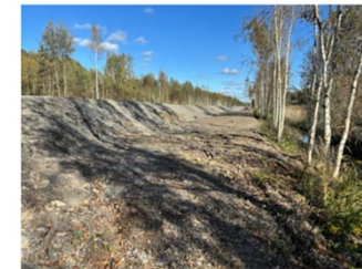
Järviojan reunapadossa on nyt kahta korkeutta: matalampi taso on ollut käytössä jo vuosi, korotus saatiin tehtyä tänä vuonna. Kuva: Päivi Merilähti / Yle
